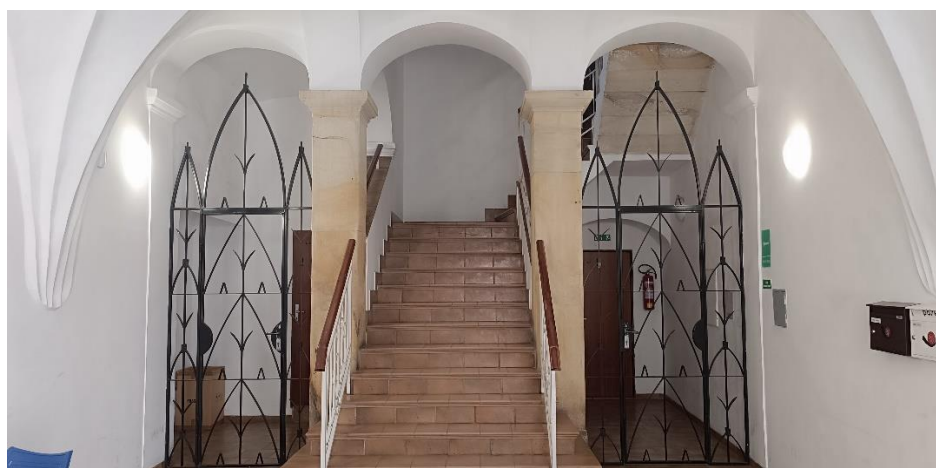
Schodiště do 2. nadzemního podlaží
