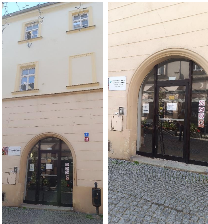
Budova ÚP ČR KoP Moravská Třebová, Cihlářova 6/13, vstup
